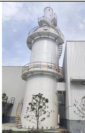
1#车间铝箔轧制油雾废气 26m 高排气筒 (DA001)
