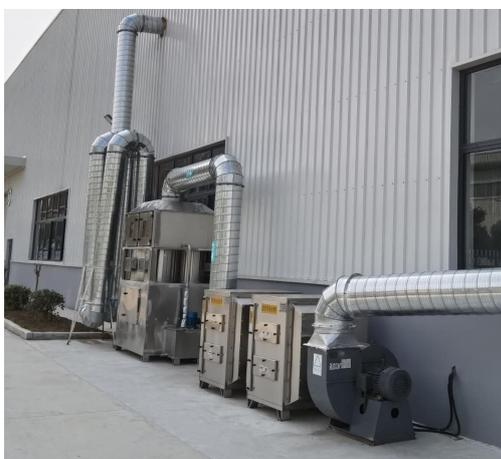
1 套旋流喷淋塔+干式过滤棉+两级活性炭吸附装置
